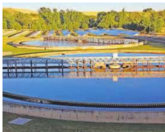
Planta fotovoltaica en la EDAR de Salamanca.
