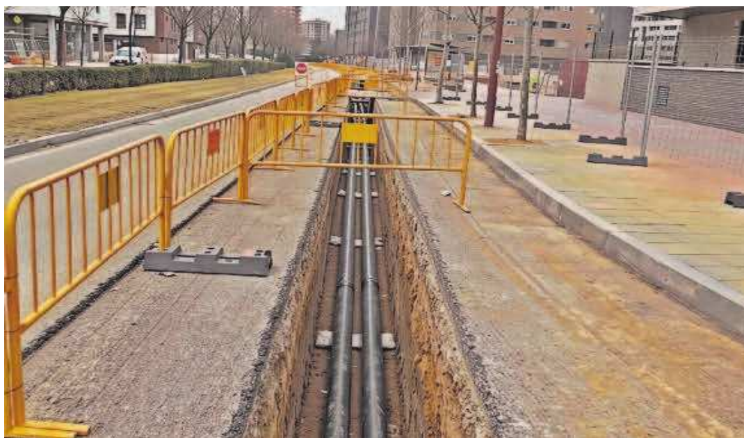
Instalación de nuevas redes de calor impulsadas por SOMACYL.
