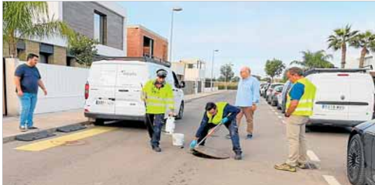
El Ayuntamiento está realizando los trabajos junto a Aqualia. LP
