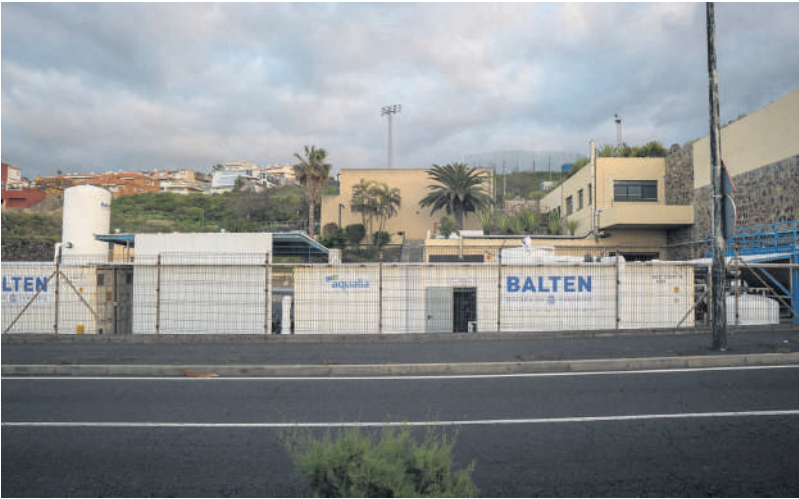
LA DEPURADORA COMARCAL DE PUNTA BRAVA REGISTRÓ EL SÁBADO UN DERRAME DE MIL LITROS. Fran Pallero
