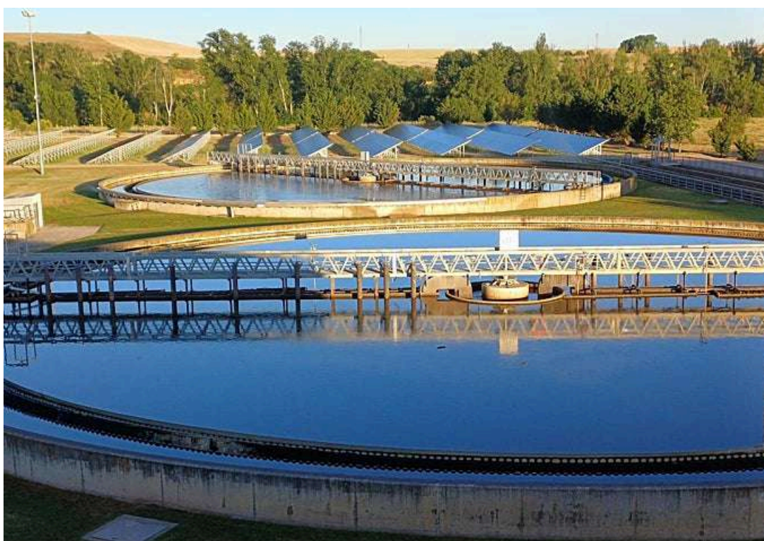
Planta fotovoltaica en la EDAR de Salamanca.
